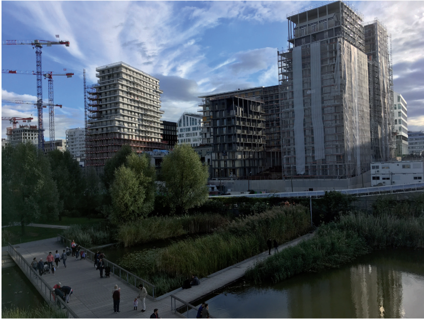
Le quartier de Clichy Batignolles se développe depuis une dizaine d'années sur des friches ferroviaires de 54 hectares (photos : Jérôme Porier)
