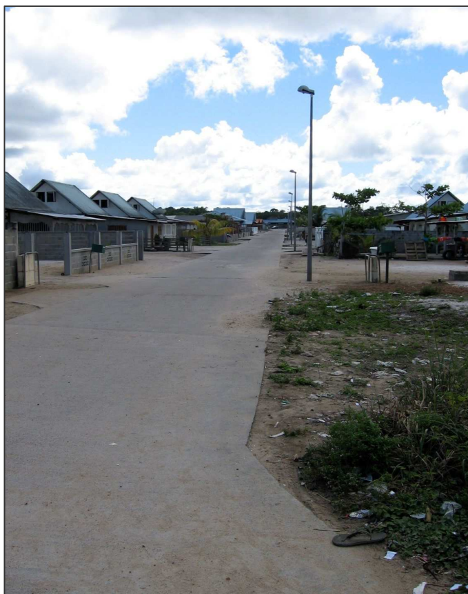
Absence de fossés pour l'évacuation des eaux pluviales
