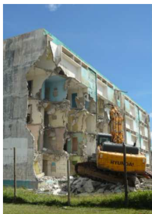
Démolition, bâtiments de Mirza
